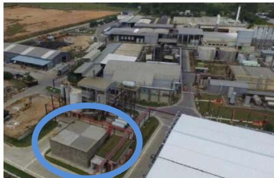
Reservatório de água
