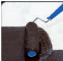
Primer para colagem de manta asfáltica
