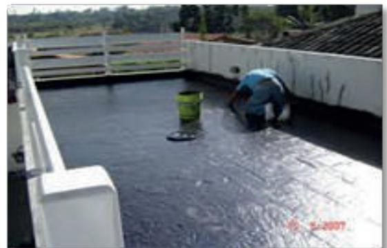
Após a aplicação do **Berço Adesivo EPDM** em toda a área prevista, aguardar o ponto de toque do produto (TAC ou ponto de Durex), que pode variar de 2 a 6 horas, dependendo das condições climáticas do local. Quando isto ocorrer, iniciar a aplicação da manta **Viapol EPDM**.
