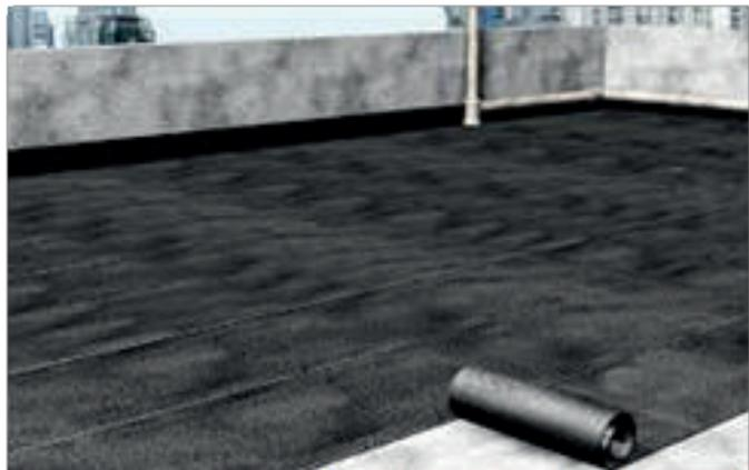
Aplicar a manta **Viapol EPDM** sobre o **Berço Adesivo EPDM** em toda a área prevista, pressionando levemente com as mãos até total aderência ao substrato. Assegurar que a manta seja aderida sem nenhuma tensão.
