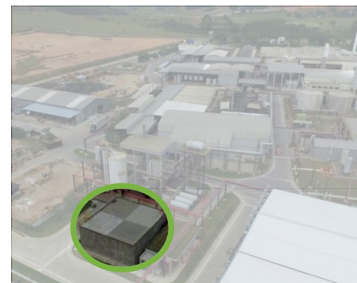
Reservatório de água (1.350.000 L)
