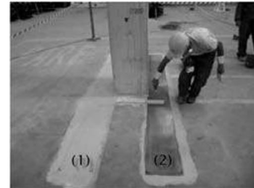
Fotografia 3.6 – Fases construtivas (1) e (2).
