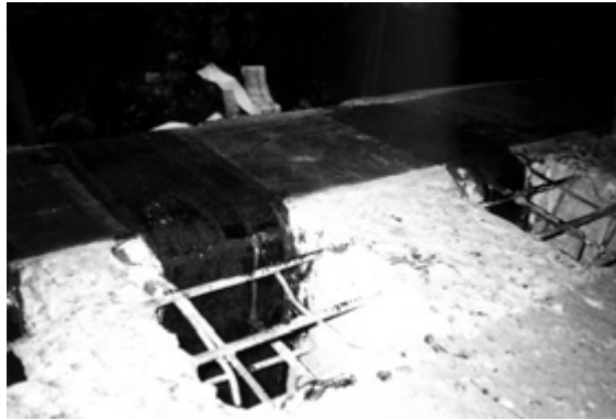
Fotografia 8.1 – As lâminas para o cisalhamento são colocadas por cima das de flexão
