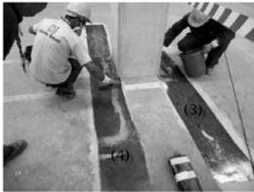
Fotografia 3.7 – Fases construtivas (3) e (4).
