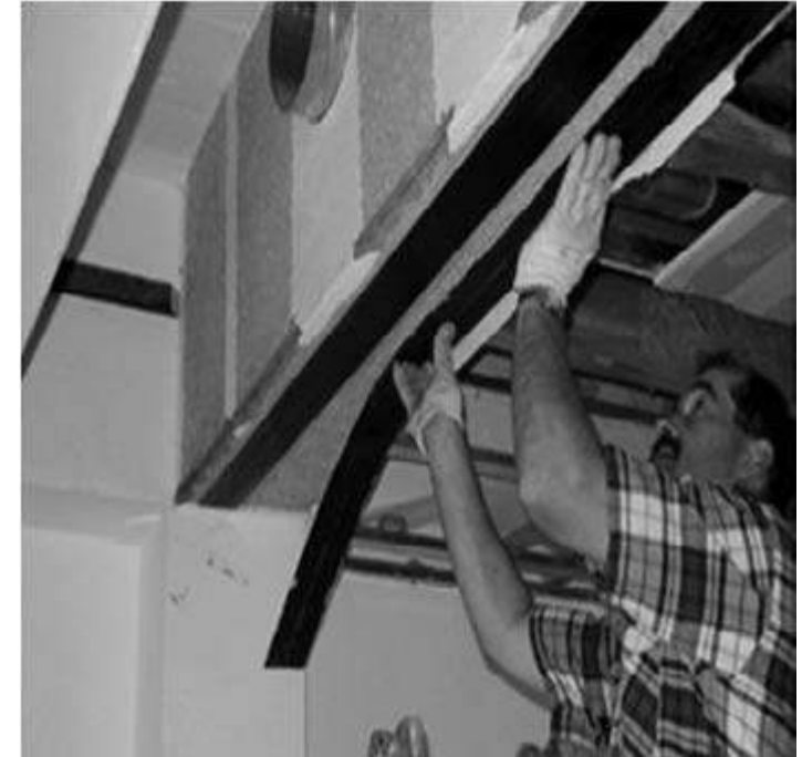
Fotografia 9.15 – Reforço de viga com laminado de fibra de carbono.
