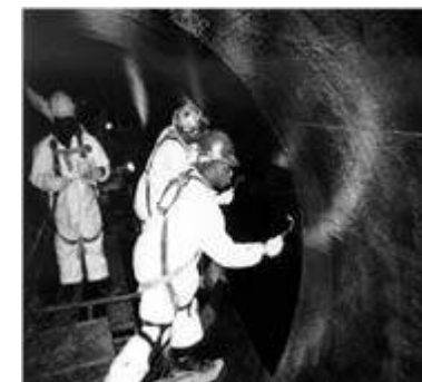
Fotografia 2.4 – Reforço de tubulações de concreto de grande diâmetro.
