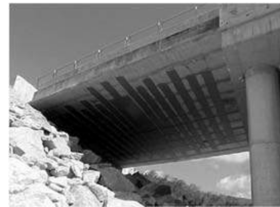
Fotografia 9.10 – Reforço de viaduto urbano em Belo Horizonte - MG. Reforço de ponte ferroviária sobre o Rio Quatis, em Aymorés - MG.
