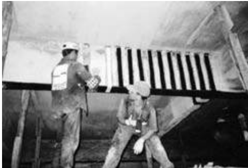
Fotografia 2.1 – Reforço de viga de concreto à flexão e ao corte.
