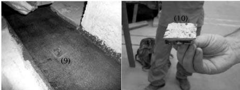
Fotografia 3.12 – Fases construtivas (9) e (10).
