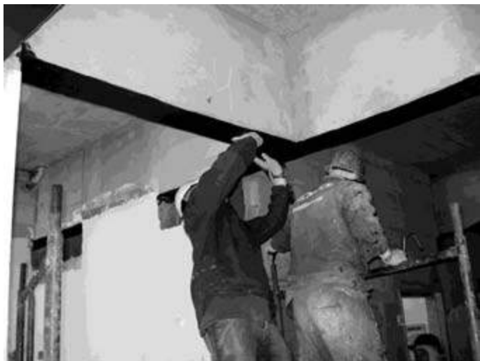
Fotografia 9.4 – Reforço de viga à flexão com fibra de carbono.
