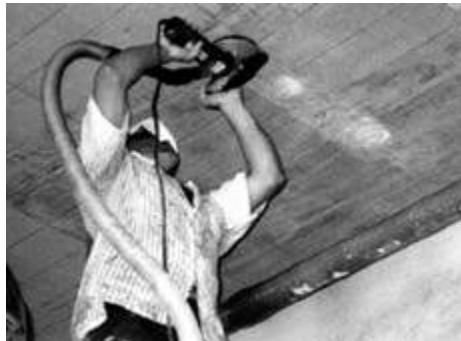
Fotografia 3.1 – Limpeza de superfície com politriz elétrica.
