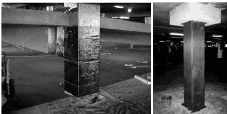
Fotografia 2.3 – Reforço de pilares por confinamento.
