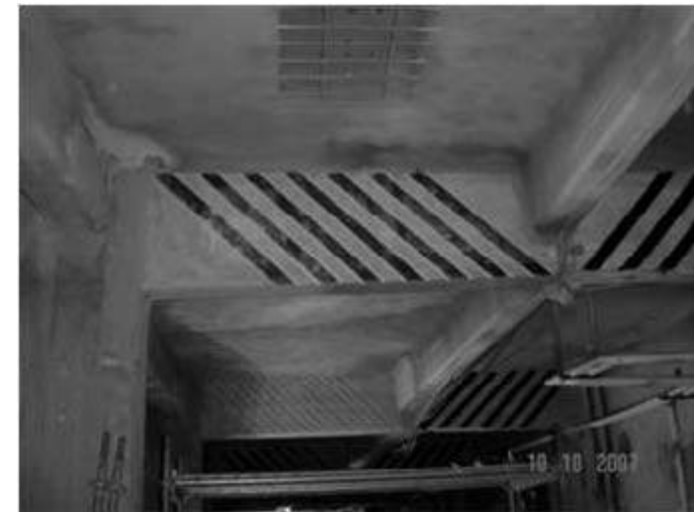
Fotografia 9.5 – Reforço de viga ao corte com fibra de carbono.
