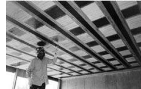
Fotografia 6.3 – Laje nervurada reforçada com laminados de fibra de carbono.
