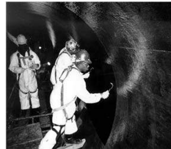
Fotografia 9.11 – Reforço de silo no Chile e tubulação em Chicago – EUA.
