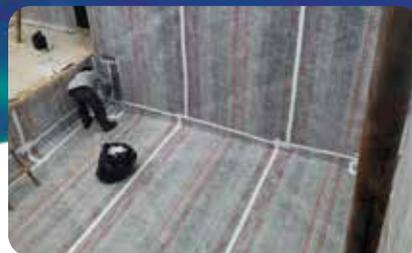
**Amphibia** é uma manta impermeável em EPDM que reage ao contato com a água, possuindo uma tecnologia autorregenerativa e autocicatrizante devendo ser aplicada preferencialmente durante as operações de pré-concretagem. Composta por uma manta polimérica, contínua e de multicamadas, com desempenho diferenciado na impermeabilização total das estruturas subterrâneas contra infiltração de água.
