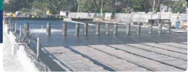
Esta é uma das linhas de produtos de alto desempenho da VIAPOL. Produzida a partir da modificação física do asfalto com polímeros que conferem à manta asfáltica excelentes resultados e total impermeabilidade da área tratada. Estruturada com não tecido de filamentos contínuos de poliéster previamente estabilizado ou véu de vidro. Atende as exigências da NBR 9952/2014.
