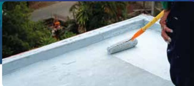
**LINHA COMPLETA DE MEMBRANAS VIAPOL** – produtos à base de resinas acrílicas, asfálticas ou Poliuretanos. Formam uma membrana impermeável, elástica e flexível de excelente desempenho sobre a superfície, garantindo a estanqueidade das áreas aplicadas.
