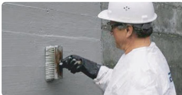
Sua ação inicia-se logo após a aplicação, penetrando nos capilares do concreto e criando cristais que selam fissuras e evitam a entrada de água, seja por pressão negativa ou positiva.
