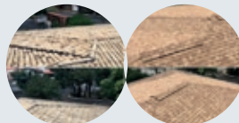
Reforme o telhado para Shingle
