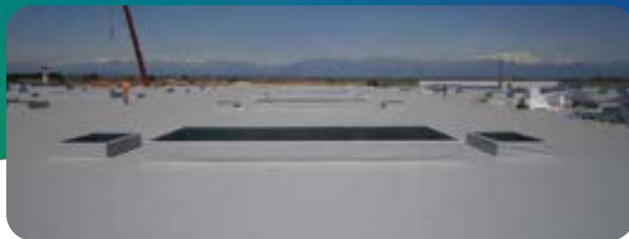
Manta PVC Viapol cobertura é uma membrana impermeabilizante sintética em PVC-P reforçada com tela de poliéster de alto desempenho, resistente aos raios ultravioletas, para impermeabilização de lajes de cobertura sem proteção mecânica.
